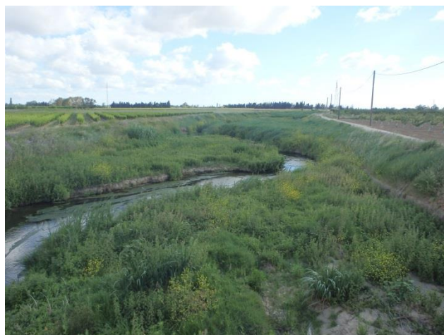
Atterrissement de sables/limons à scarifier en aval d'Alneya
