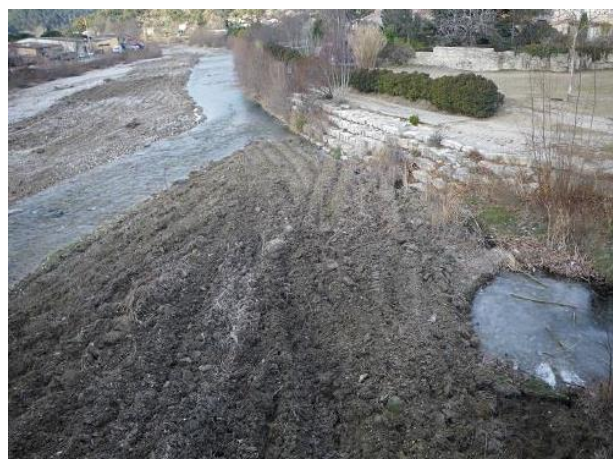
Atterrissement après scarification (février 2012, ouvèze, Vaison, SMOP)
