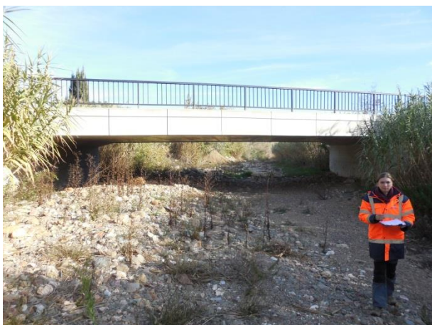
Atterrissement à araser en rive gauche sous le pont de la RD615
