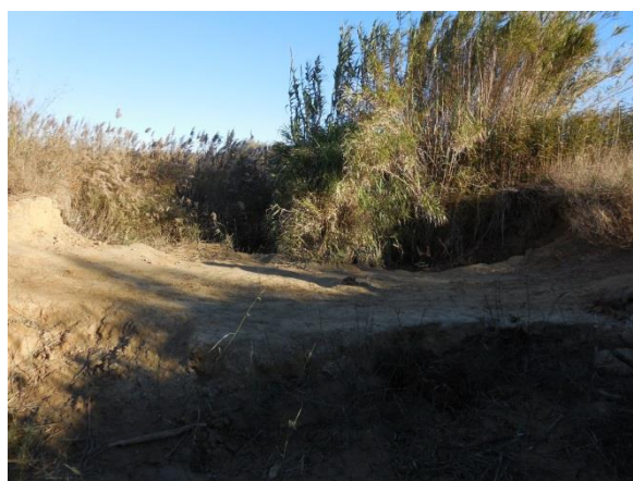
Brèche dans une digue du Réart aval
