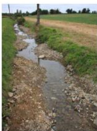
Exemple d'opération de recharge sédimentaire dans un secteur de cours d'eau incisé sans enjeux hydrauliques significatifs (Magnerolles, ONEMA 2010)
