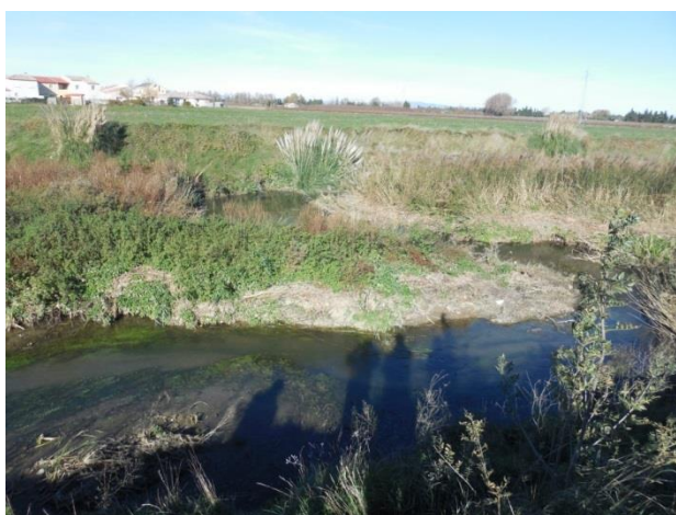
Atterrissement végétalisé réduisant la capacité hydraulique
