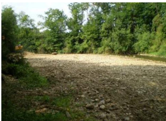
Atterrissement après travaux : dévégétalisation, griffage et régalinge (2008, Limone, SIABH)
