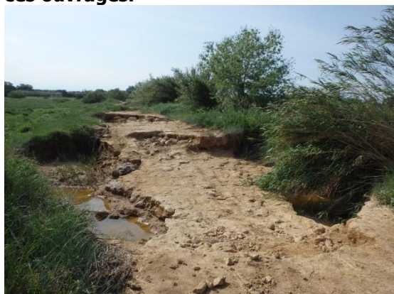
Brèche en formation dans la digue rive droite
